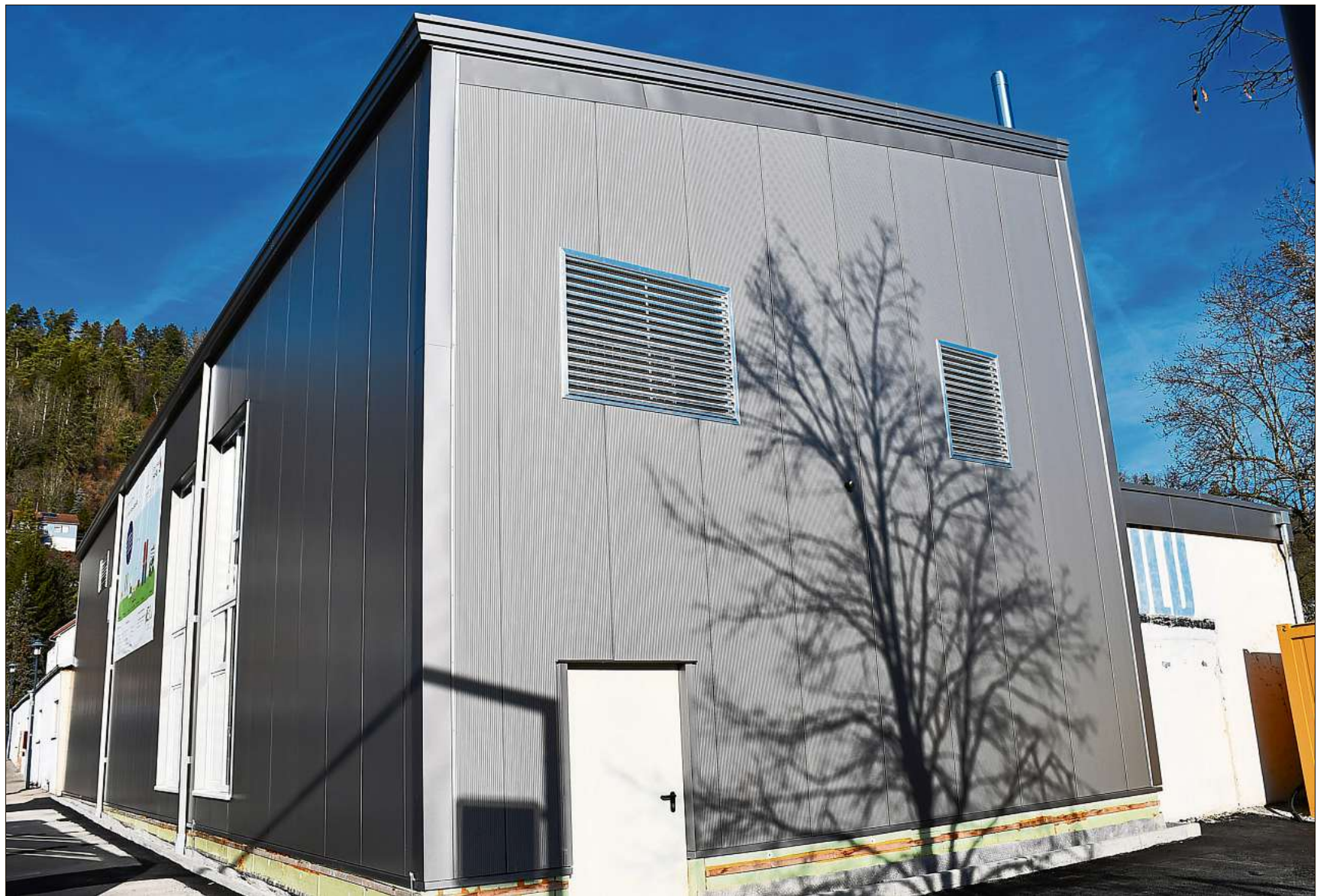
Die Heizzentrale in der Horber Weststadt
