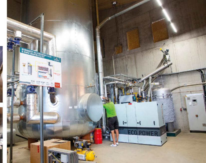
Unser neues Energiekonzept konzentriert sich überwiegend auf erneuerbare und nachhaltige Energiegewinnung: Was uns warm hält, wenn es draußen kalt ist, sind unsere Hackschnitzel-Heizung und unser Holzvergaser mit Blockheizkraftwerk. Mit beiden Anlagen zusammen erzeugen wir bis zu 660 kW thermische und 50 kW elektrische
